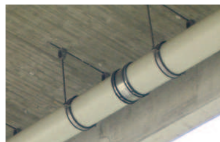
Připevnění drenážního potrubí mostu
