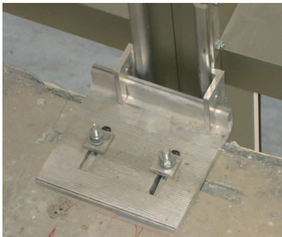
Kotva pro předsazené fasády - připevnění k horní ploše desky
